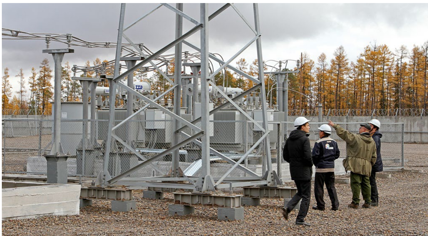
ВЛ 220 кВ «Чернышевский — Мирный — Ленск — Пеледуй» с отпайкой до НПС12
